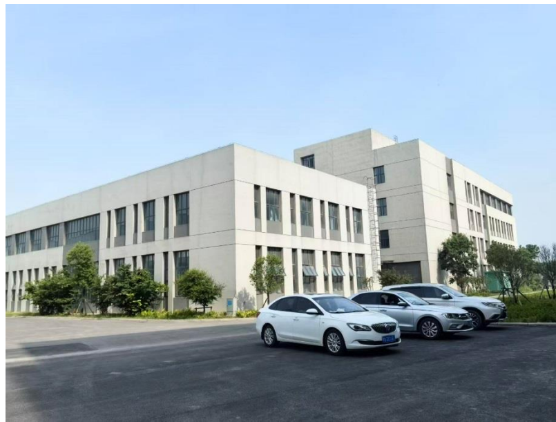
厂房西侧科技楼
